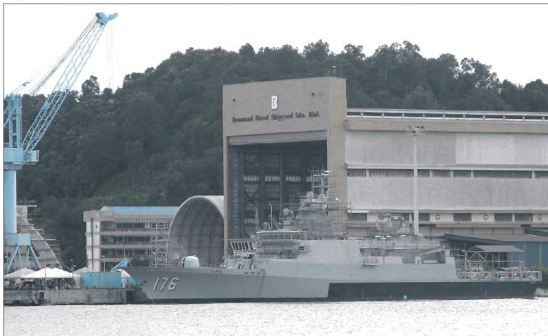
Строительство корвета типа «Кедах» на верфи компании «Боустед нейвл шипьярд»
